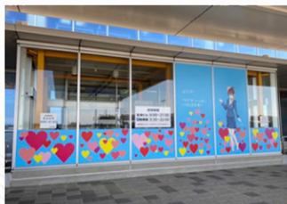
茨城空港 インクジェットフィルム工事
